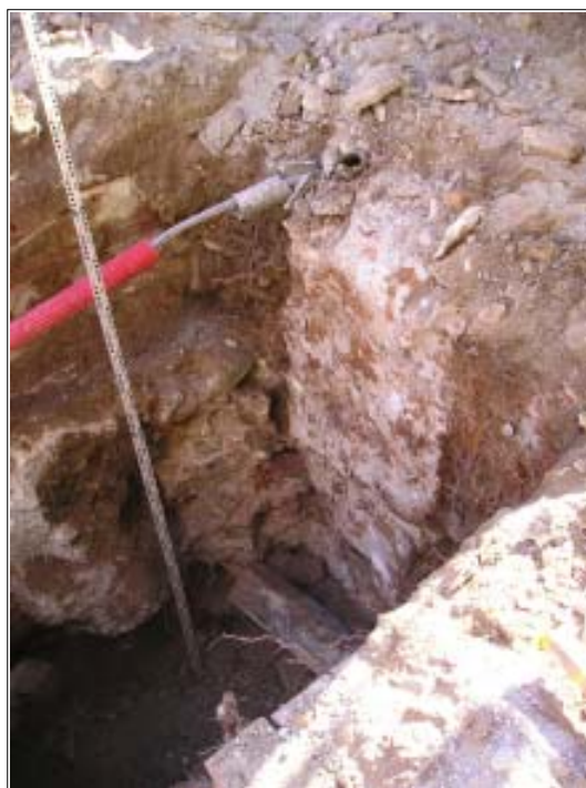
Mur U.E.49, localitzat durant el desmuntatge del mur U.E.10
