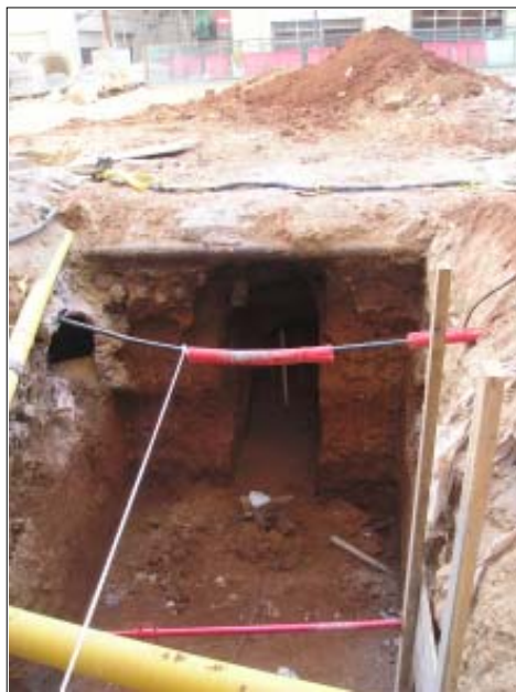
Extrem sud de la cambra, amb la rasa que connectava amb el tub de l'Avinguda. S'observen les restes del mur U.E.206, mentre que l'U.E.233 ja hauria quedat desmuntada en aquest espai pel pas del col·lector
