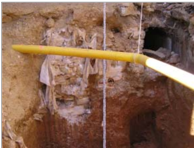
Límit nord de la cambra, amb el mur U.E.206 i l'estructura U.E.233, així com l'antic col·lector aprofitat per al pas del tub
