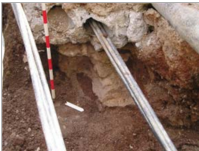
Restes del mur U.E.22
